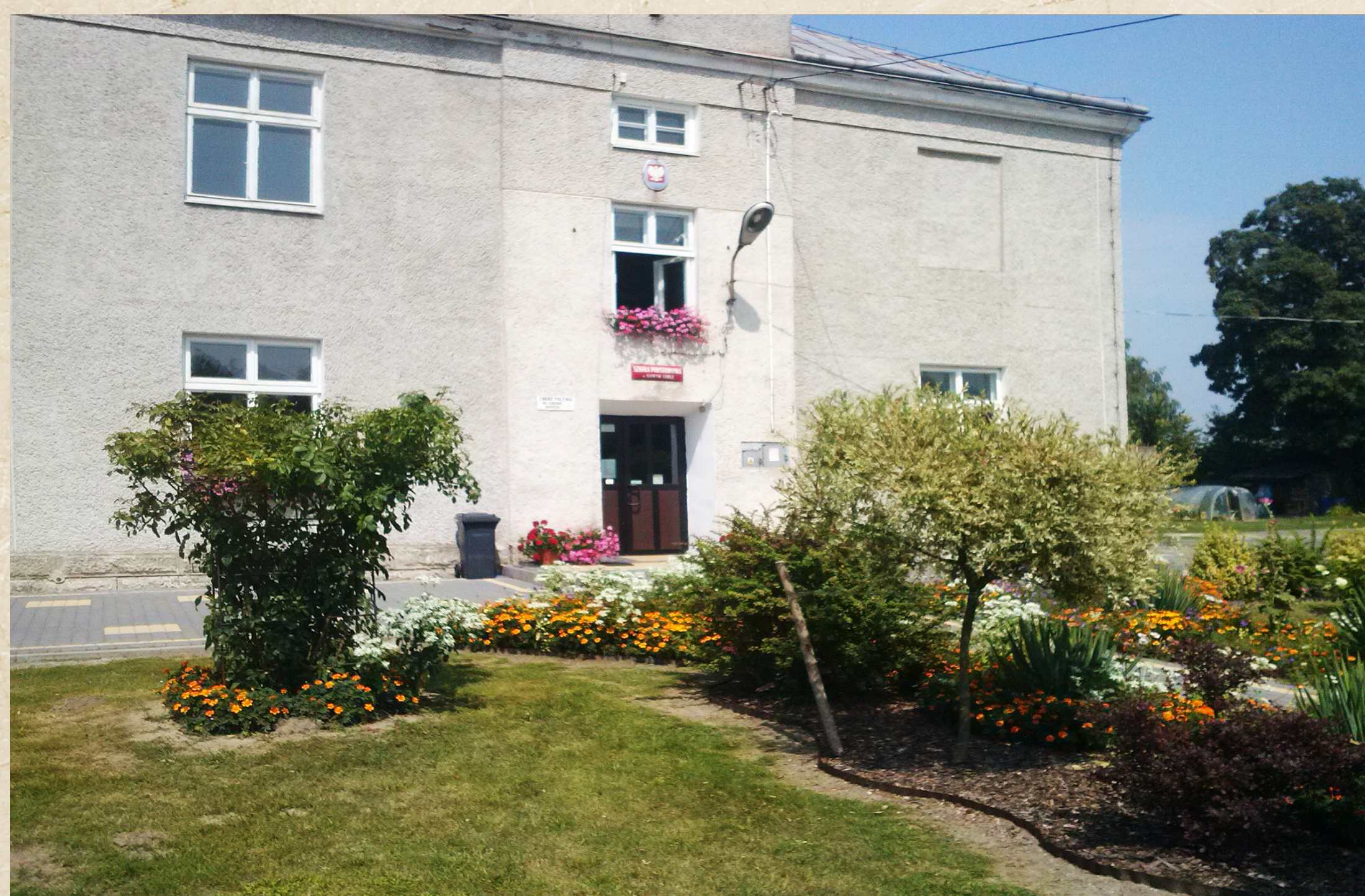
Szkoła Podstawowa w Nowym Siole przed remontem, 2016 r. (zbiory Szkoły Podstawowej w Nowym Siole)
