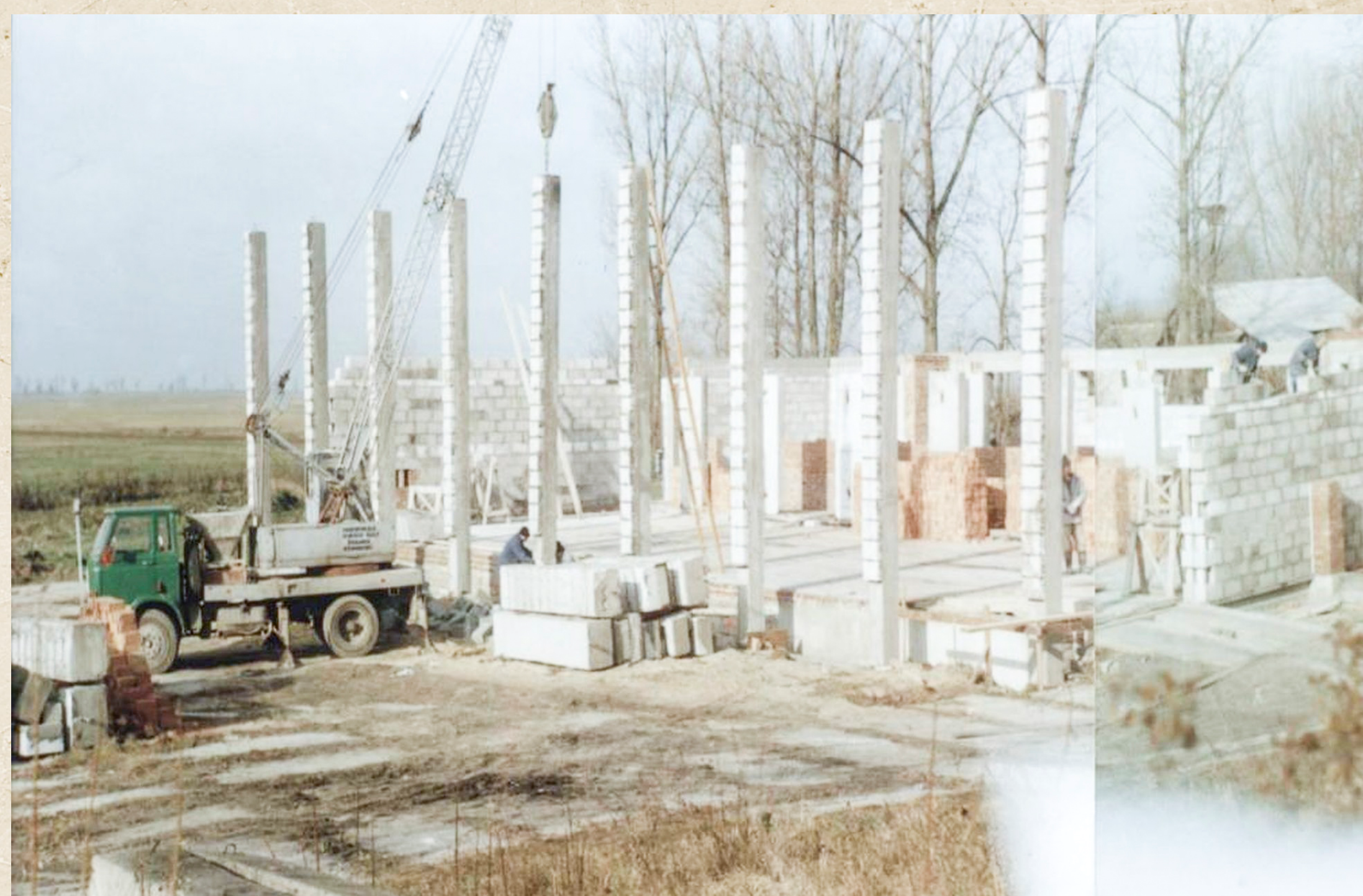
Budowa hali sportowej przy szkole podstawowej, 1997 r. (zbiory Szkoły Podstawowej w Nowym Lublińcu)
