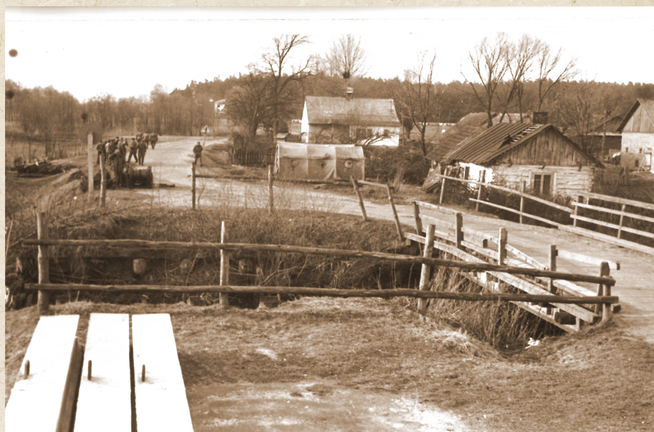
Budowa mostu na ulicy Niemstowskiej w Cieszanowie, 1986 r. (zbiory Edwarda Dziaduły)
