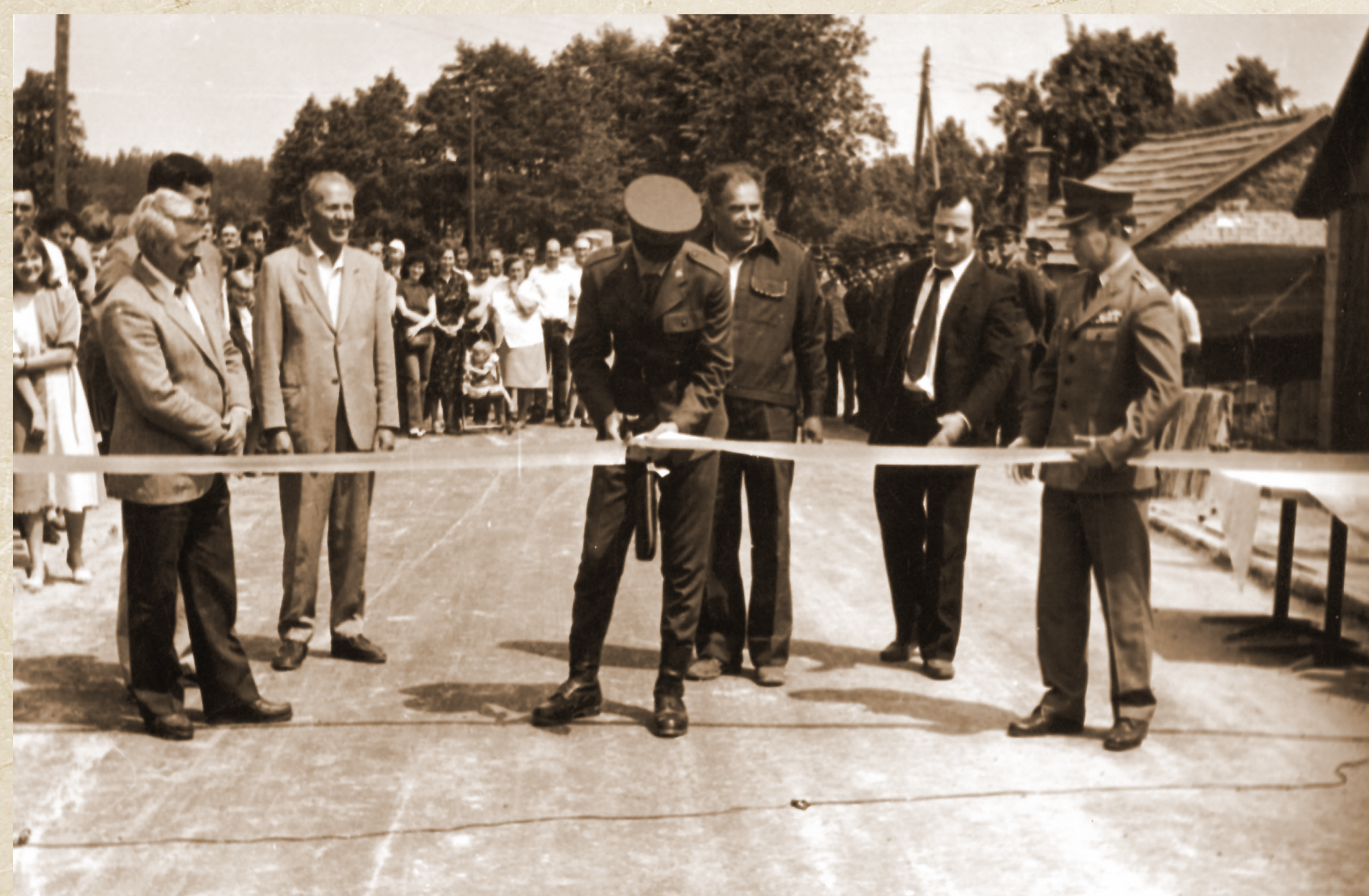
Uroczystość oddania do użytku mostu na ulicy Niemstowskiej w Cieszanowie, 1986 r. (zbiory Edwarda Dziaduły)
