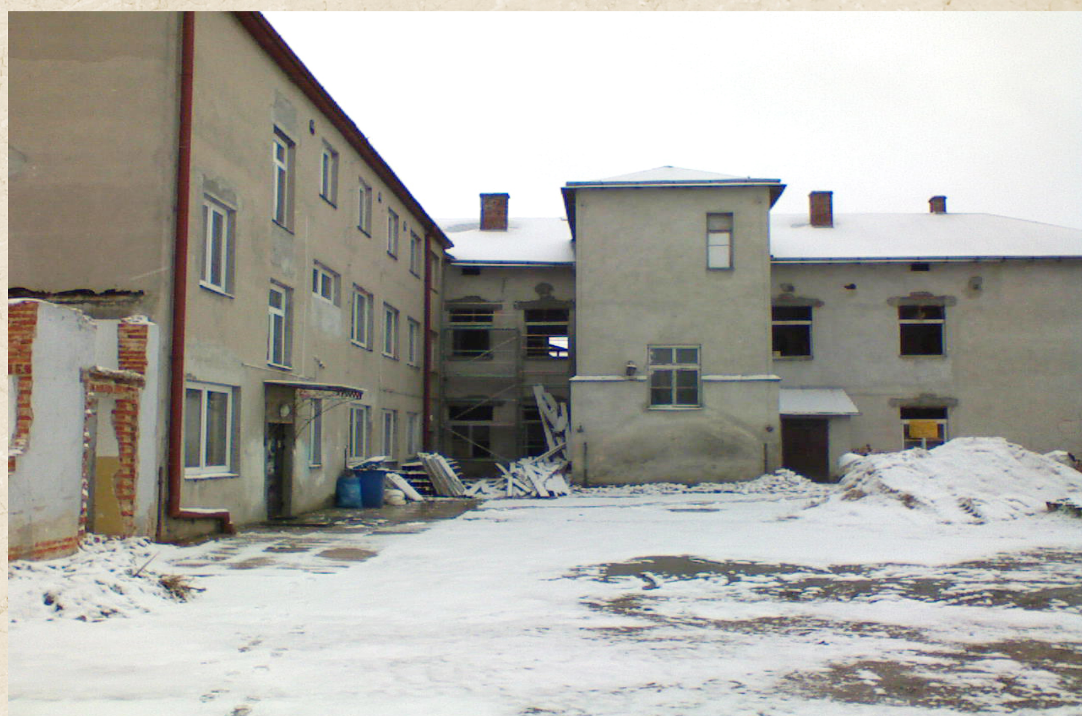
Rozbudowa i modernizacja budynku przy ulicy Sobieskiego na Centrum Edukacji Wczesnoszkolnej, 2008 r. (zbiory Mariusza Szlezaka)
