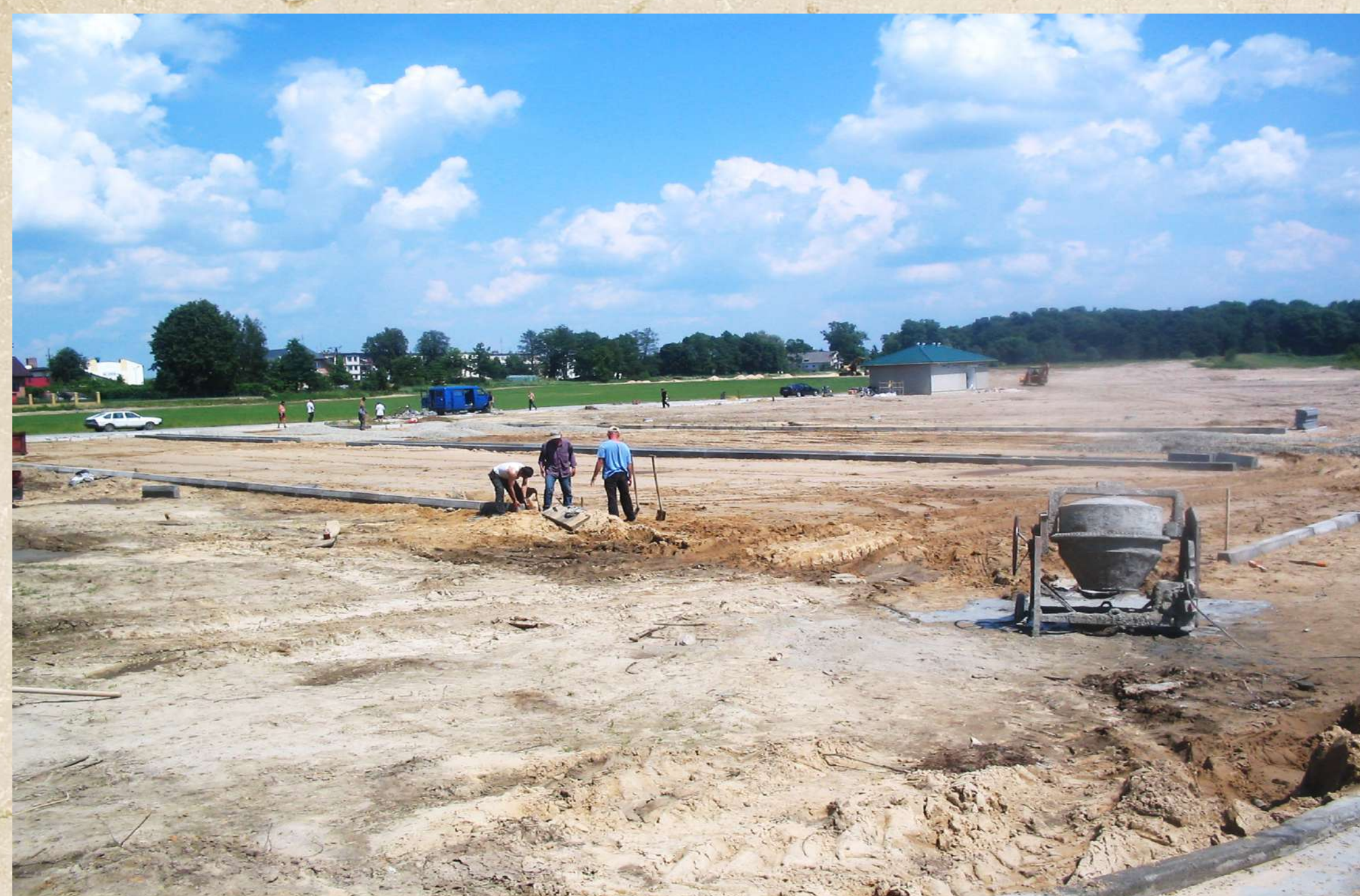
Prace budowlane na terenie kąpieliska „Wędrowiec” w Cieszanowie, 2005 r. (zbiory Mariusza Szlezaka)
