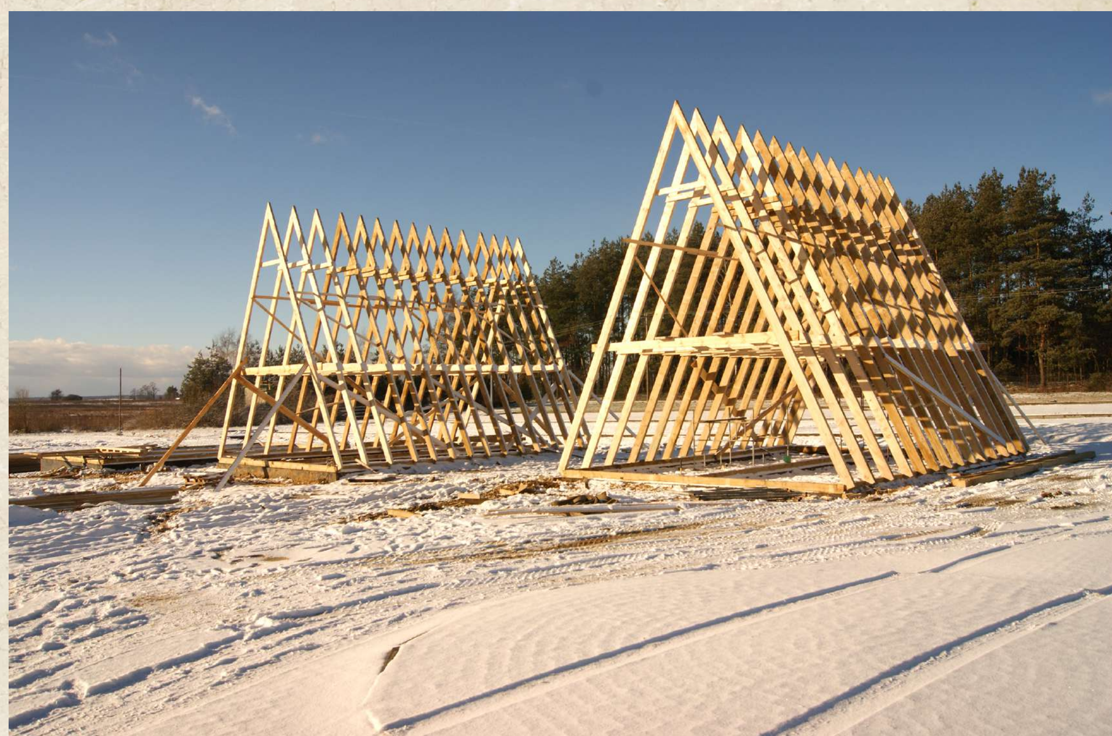
Budowa domków letniskowych na terenie kąpieliska „Wędrowiec” w Cieszanowie, 2012 r. (zbiory Mariusza Szlezaka)
