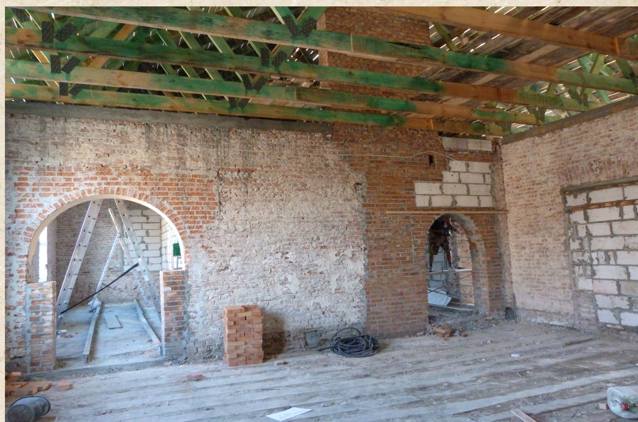
Prace remontowe wewnątrz budynku Miejskiej Biblioteki Publicznej w Cieszanowie, 2012 r. (zbiory Miejskiej Biblioteki Publicznej w Cieszanowie)
