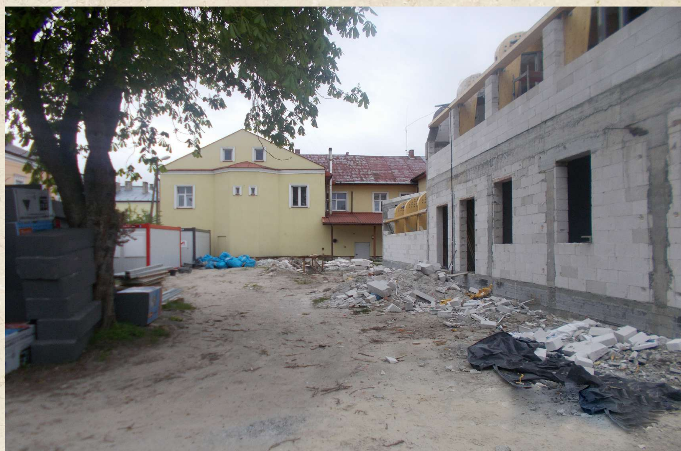
Budowa nowego budynku Urzędu Miasta i Gminy Cieszanów, 2021 r. (zbiory Urzędu Miasta i Gminy Cieszanów)
