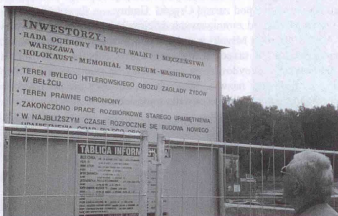
Tablica placu budowy na terenie byłego obozu zagłady Żydów, Belżec, lipiec 2003, fot. A. Sz.
